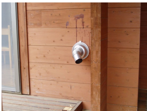
配管も実際に接続して使える状態での展示にご協力させていただいております。
