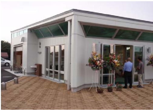
【バイオマス体験棟】 前の路盤には、山武杉が使われています。
